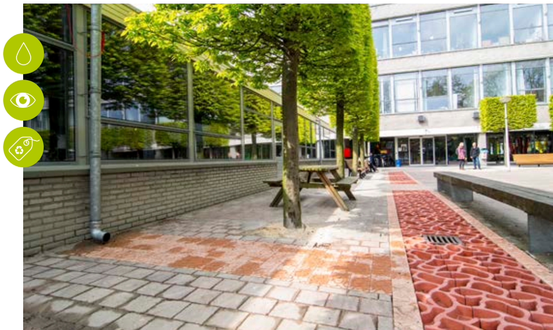
WOW Amsterdam - Vorhandene Fallrohre und Gullys wurden in das Design integriert, um eine optimale Lagerung und Versickerung ohne Überflutung zu erreichen.
