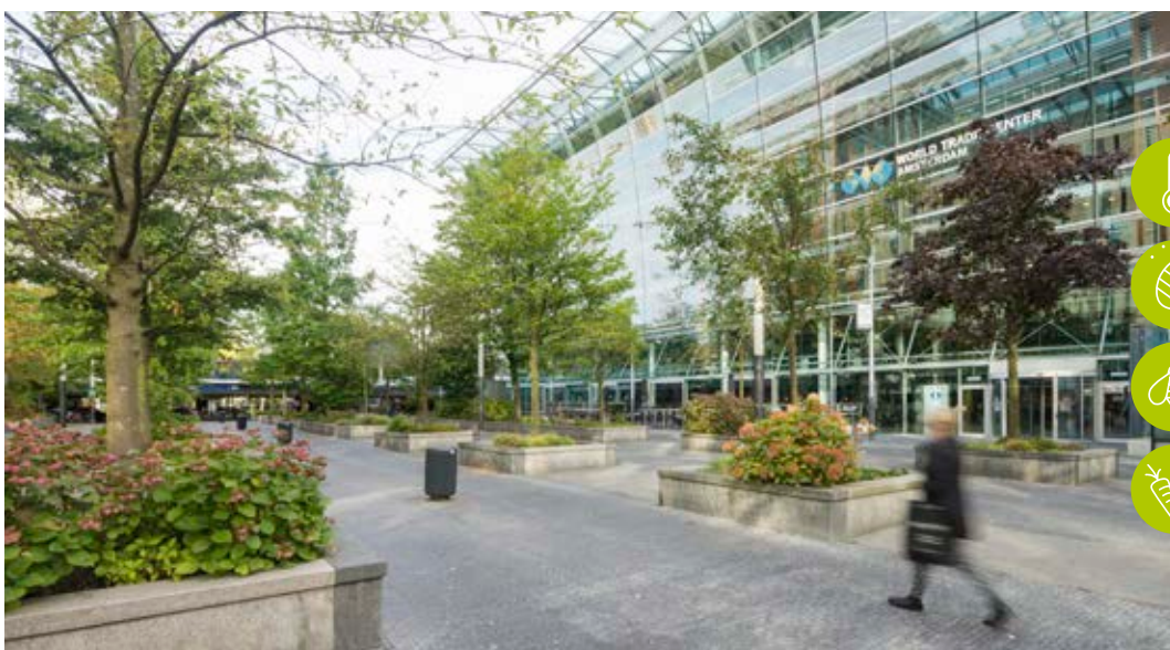
In Amsterdam (Zuidplein) wurden siebzig Wachstumsplätze für Bäume in Form von versenkten Containern in einem unterirdischen Fahrradschuppen in das Gebäude integriert.
