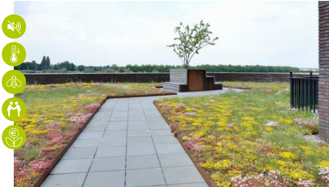
Maasboulevard Venlo, ING 3W, Umbau eines Kiesdaches zu einem schöneren und artenreicheres Gründach. Förderung des Verkaufs von Wohnungen.
